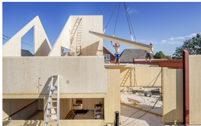
Plaatsing van een gezinswoning in CLT FOTO JOREN DE WEERDT
